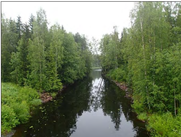
Rutolan Telataipaleen vanhan myllyn paikalla on nykyisin uittokanava. Kuvattu pohjois-
